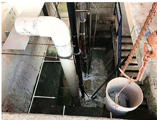
Figura 7.26 Estación de Bombeo aguas residuales
