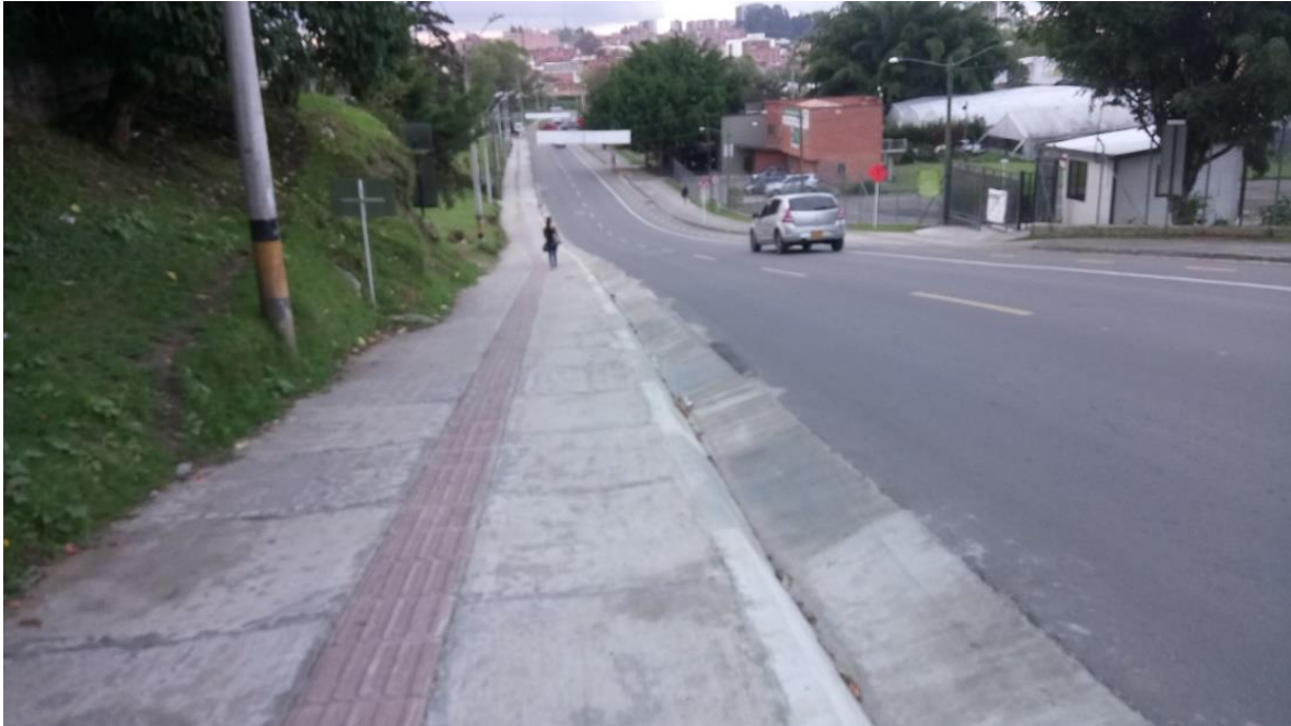
Figura.4.6-1 Conformación de los andenes de la carrera 56
