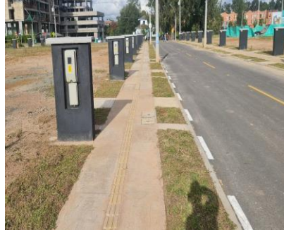
Figura 2. Construcción de andenes 2022. Comuna 1 Centro, Liborio Mejía
