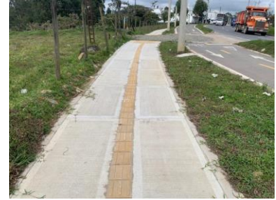
Figura 3. Construcción de andenes 2022. Comuna 1 Centro, Liborio Mejía: Sector Tranvía.
