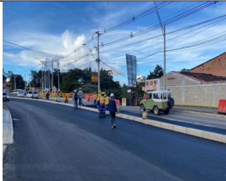
Figura 23. Construcción, ampliación o adecuación de vías urbanas y rurales 2022. Comuna 1 Centro, Liborio Mejía: Tramo Belén-Fiscalía
