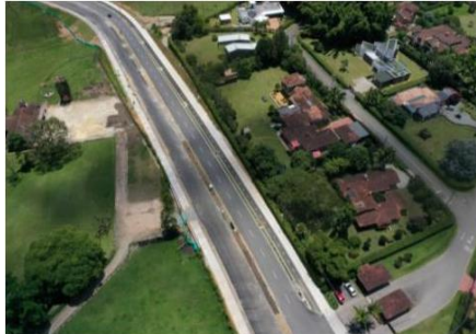
Figura 35. Construcción, ampliación o adecuación de vías urbanas y rurales 2022. Corregimiento Sur: vía nueva Jumbo-Las Torres.
