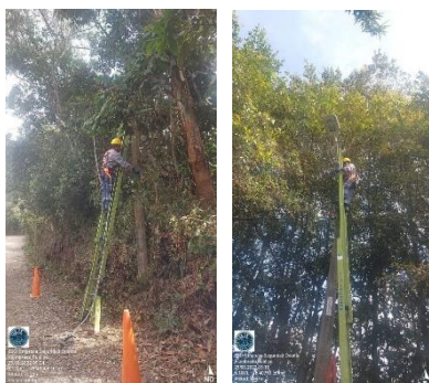
Figura 70. Mantenimiento y expansión del sistema de alumbrado público 2022. Corregimiento Sur.
