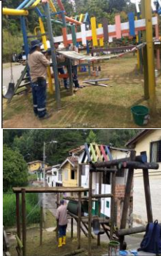
Figura 54. Mantenimiento de equipamientos para la integración ciudadana 2022. Comuna 1, Liborio Mejía: mantenimiento de parques infantiles Quebrada Arriba y Las Playas.
