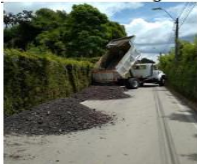
Figura 34. Construcción, ampliación o adecuación de vías urbanas y rurales 2022. Corregimiento Sur: Pavimentación vereda Vilachuaga.
