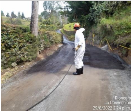
Rionegro La Convención 29/8/2022 2:24 p. m. Figura 38. Construcción, ampliación o adecuación de vías urbanas y rurales 2022. Corregimiento Occidente: pavimentación vereda La Convención.
