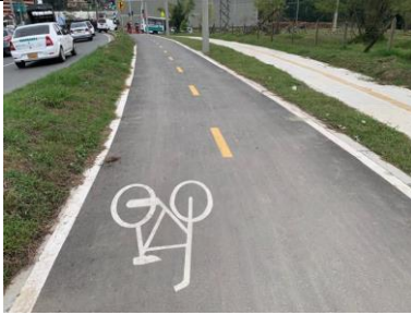
Figura 16. Construcción de Ciclorrutas 2022. Comuna 1, Liborio Mejía: sector Tranvía.
