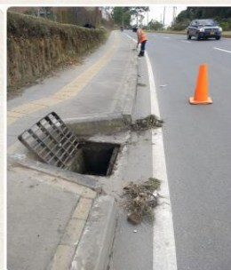
Figura 5. Construcción de andenes 2022. Comuna 1 Centro, Liborio Mejía: vía El Tranvía.
