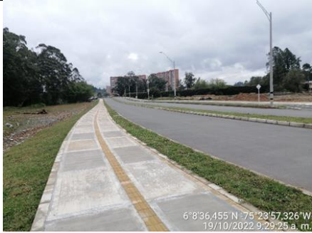
Figura 12. Construcción de andenes 2022. Corregimiento Sur, Gilberto Echeverri Mejía: Villas de Llanogrande-Alto Vallejo (Transversal 2).
