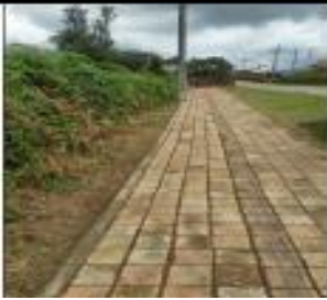
Figura 15. Construcción de andenes 2022. Corregimiento Centro, Fontibón vía vereda Las Cuchillas.
