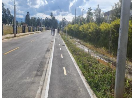
Figura 17. Construcción de Ciclorrutas 2022. Comuna 1, Liborio Mejía
