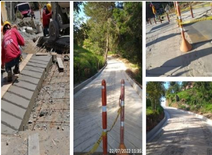
Figura 45. Construcción, ampliación o adecuación de vías urbanas y rurales 2022. Construcción de placa huella Corregimiento Centro: vereda Abreo, sector Villa Sofia.
