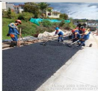
Figura 22. Construcción de Ciclorrutas 2022. Comuna 4, El Porvenir: Tramo Comando-Tanque Abreo.
