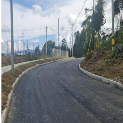
Figura 41. Construcción, ampliación o adecuación de vías urbanas y rurales 2022. Corregimiento Occidente: Pavimentación, zona E.
