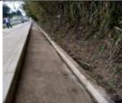
Figura 10. Construcción de andenes 2022. Comuna 4 El Porvenir: Linda Granja.
