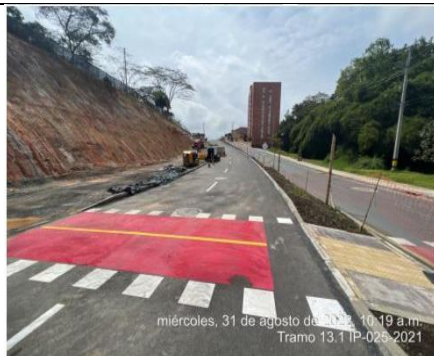
Figura 19. Construcción de Ciclorrutas 2022. Comuna 2 San Antonio: Calle 24, desde Glorieta Libertadores hacia Pietra Santa.
