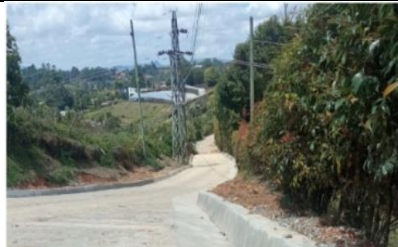
Figura 43. Construcción de placa huella 2022. Corregimiento Centro: vereda El Carmín, sector Loma Linda
