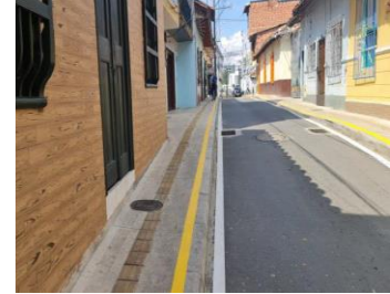
Figura 6. Construcción de andenes 2022. Comuna 1 Centro, Liborio Mejía: Sector Cr 50 entre calles 53 y 54.
