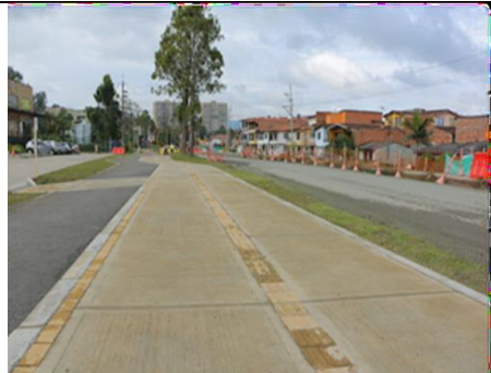
Figura 9. Construcción de andenes 2022. Comuna 4 El Porvenir: Tramo Comando-Alto Vallejo.
