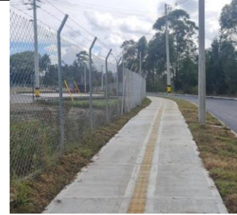
Figura 14. Construcción de andenes 2022. Corregimiento Occidente, José María Córdoba: Aeropuerto-Zona E
