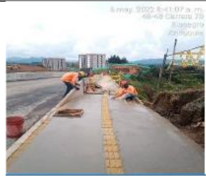
Figura 11. Construcción de andenes 2022. Corregimiento Centro, tramo Comando-Tanque Abreo.
