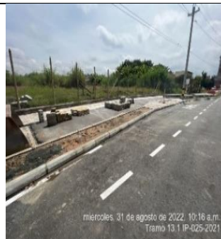
Figura 27. Construcción, ampliación o adecuación de vías urbanas y rurales 2022. Comuna 2 San Antonio: en el Tramo 13.1
