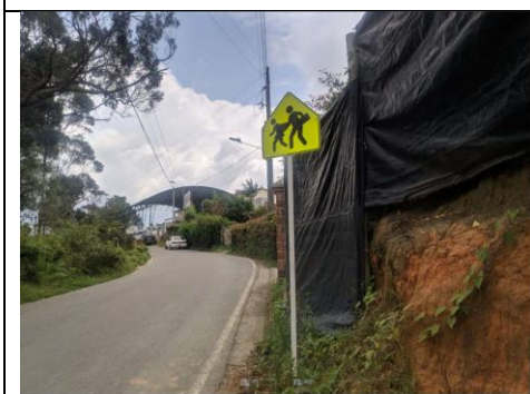
Figura 76. Señalización vial vertical 2022.
