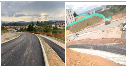
Figura 21. Construcción de Ciclorrutas 2022. Comuna 4, El Porvenir: Tramo Comando-Tanque.
