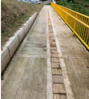
Figura 4. Construcción de andenes 2022. Comuna 1 Centro, Liborio Mejía: Fontibón, sector Falda de El Palo.
