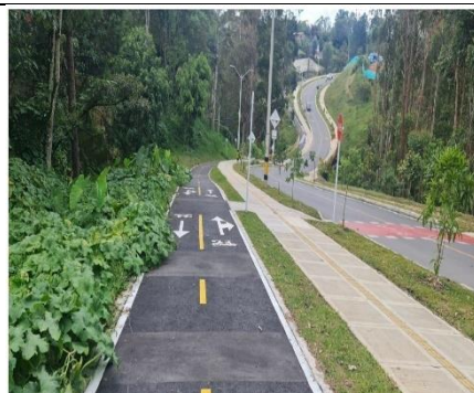
Figura 20. Construcción de Ciclorrutas 2022. Comuna 2 San Antonio: Tramo San Antonio-Ojo de Agua.
