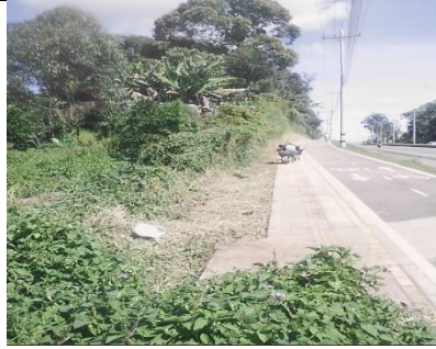
Figura 13. Construcción de andenes 2022. Corregimiento Occidente, José María Córdoba: Aeropuerto-antigua Hostería.
