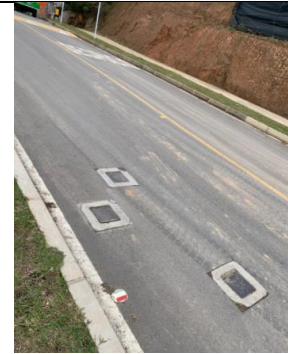
Figura 25. Construcción, ampliación o adecuación de vías urbanas y rurales 2022. Comuna 1 Centro, Liborio Mejía: Fontibón, sector Falda de El Palo.
