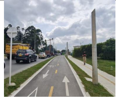
Figura 18. Construcción de Ciclorrutas 2022. Comuna 1, Liborio Mejía: sector Tranvía
