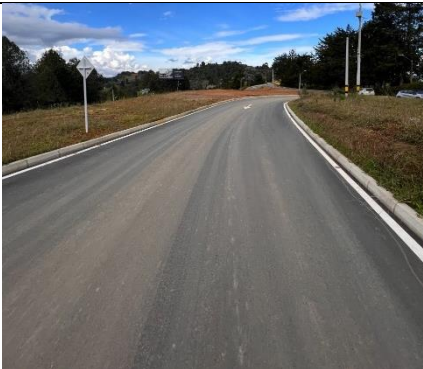
Figura 37. Construcción, ampliación o adecuación de vías urbanas y rurales 2022. Corregimiento Occidente: Pavimentación vereda El Tablazo, parte alta.
