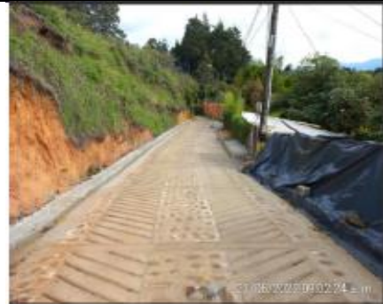
Figura 47. Construcción, ampliación o adecuación de vías urbanas y rurales 2022. Construcción de placa huella Corregimiento Centro: vereda Las Cuchillas, sector Paulino García.
