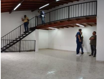
Figura 58. Mantenimiento de equipamientos para la integración ciudadana 2022. Comuna 1, Liborio Mejía: Caseta Comunal Mirador de San Nicolás.
