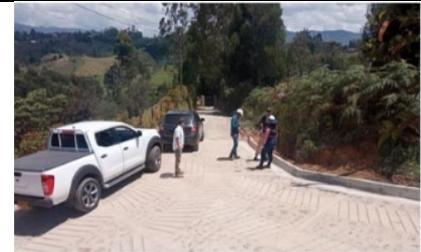
Figura 44. Construcción de placa huella 2022. Corregimiento Centro: vereda El Carmín, sector Loma Linda
