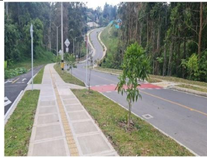
Figura 8. Construcción de andenes 2022. Comuna 2 San Antonio: tramo San Antonio-Ojo de Agua
