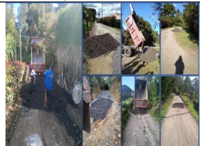
Figura 50. Construcción, ampliación o adecuación de vías urbanas y rurales 2022. Construcción de placa huella: Corregimiento Norte: veredas Los Pinos, La Laja y San Luis.
