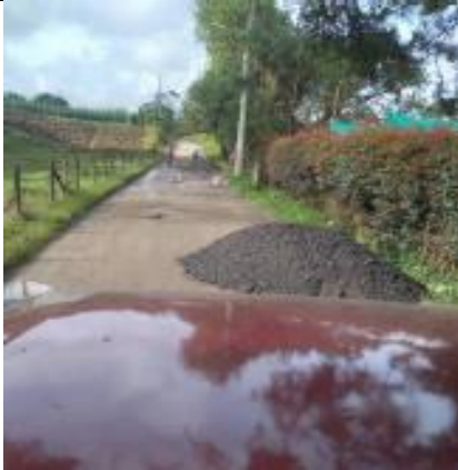
Figura 40. Construcción, ampliación o adecuación de vías urbanas y rurales 2022. Corregimiento Occidente: Pavimentación vereda El Tablazo.
