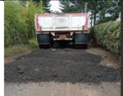
Figura 46. Construcción, ampliación o adecuación de vías urbanas y rurales 2022. Construcción de placa huella Corregimiento Centro: vereda Abreo.
