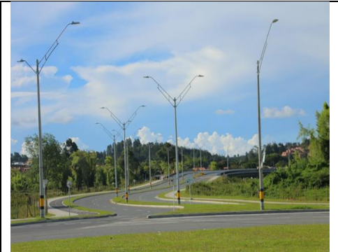
Figura 75. Mantenimiento y expansión del sistema de alumbrado público 2022.
