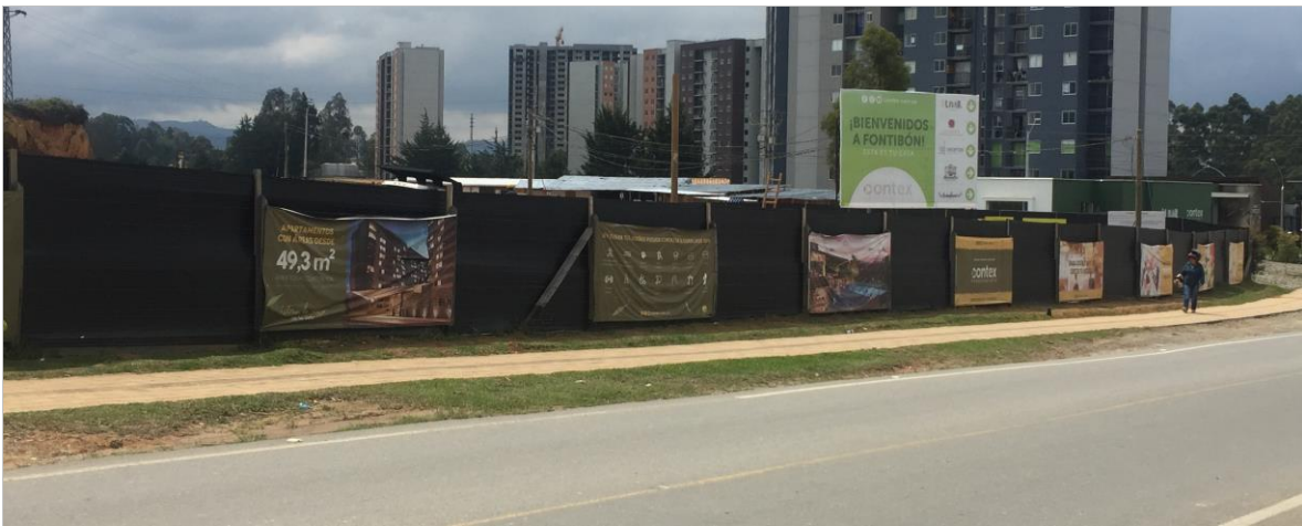
IMAGEN 8. PROYECTO OLIVAR APARTAMENTOS EN CONSTRUCCIÓN
