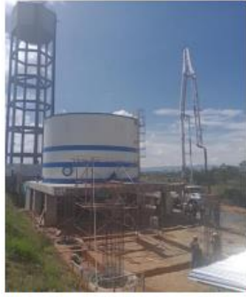
Figura 3. Bombeo de concreto de pilas
