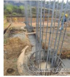
Figura 4. Conformación de vigas de fundación
